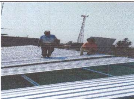
Foto 5: sustitución de duralita por lamina troquelada calibre 26 y mantenimiento de soporte de metal
