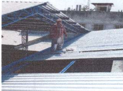
Foto 1: sustitución de duralita por lamina troquelada calibre 26 y mantenimiento de soporte de metal
