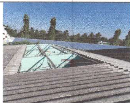
Foto 6: sustitución de duralita por lamina troquelada calibre 26 y mantenimiento de soporte de metal
