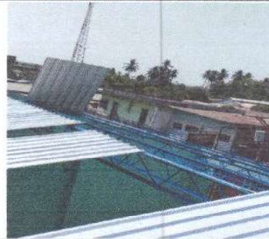
Foto 2: sustitución de duralita por lamina troquelada calibre 26 y mantenimiento de soporte de metal
